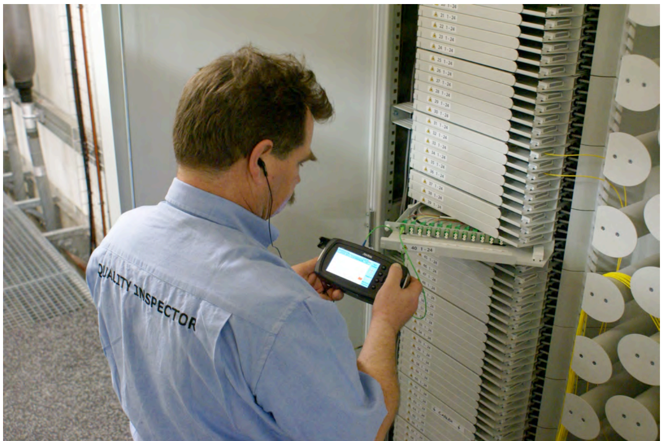
Bild: Ein ‚Quality Inspector‘ von Exanovis kontrolliert die FTTH Anschlüsse in der Zentrale
